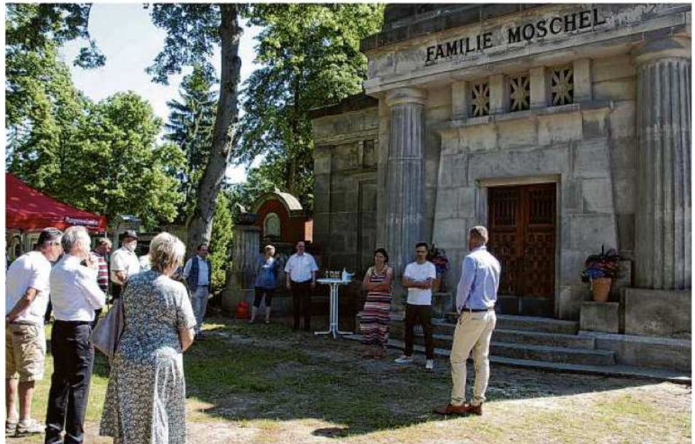
Einweihung: Das denkmalgeschützte Moschel-Mausoleum auf dem historischen Friedhof in Angermünde kann nach aufwendiger Sanierung nun wieder genutzt werden. Fotos (2): Daniela Windolff
