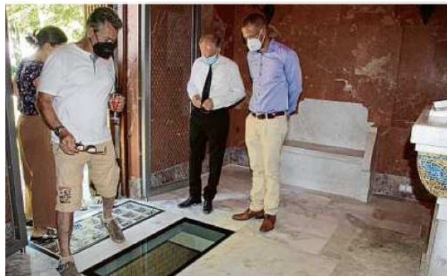
Im sanierten Moschel-Mausoleum auf dem Friedhof in Angermünde bietet ein trittfestes Fenster Einblicke in die Gruft.
