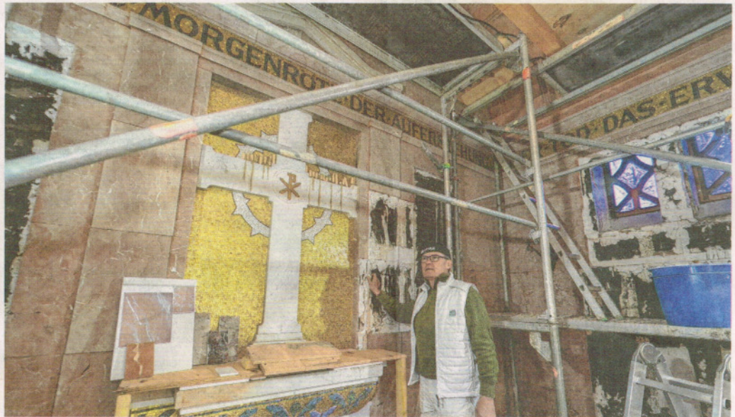
Arbeiten laufen: Olaf Kalkutschke von der Firma Universal-Putz GmbH arbeitet im Auftrag der Stadt Angermünde an der Sanierung des Innenraums des Moschel-Mausoleums. Insgesamt 182.000 Euro sollen die Baumaßnahmen kosten.
